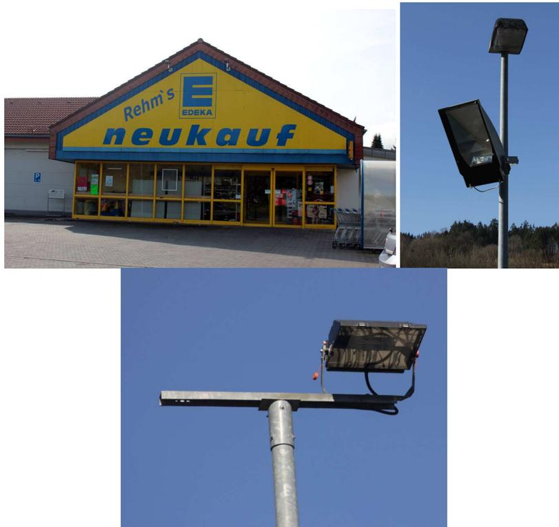
Diese wurden ersetzt durch 50 W LED-Strahler, ebenso die HQL-Parkplatzbeleuchtung durch LED-Strahler. Die Strahler zur Anstrahlung des Schildes wurden an der Fassade installiert und strahlen nur nach unten.
