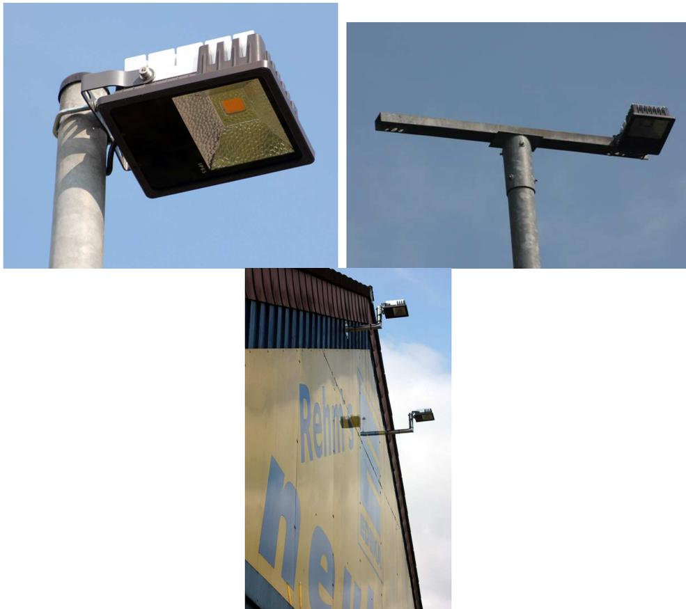
Die Leuchtstoffröhren wurden durch LED-Röhren ersetzt, eine Abstrahlung nach oben und vorne wurde durch eine eingebaute Blende unterdrückt
