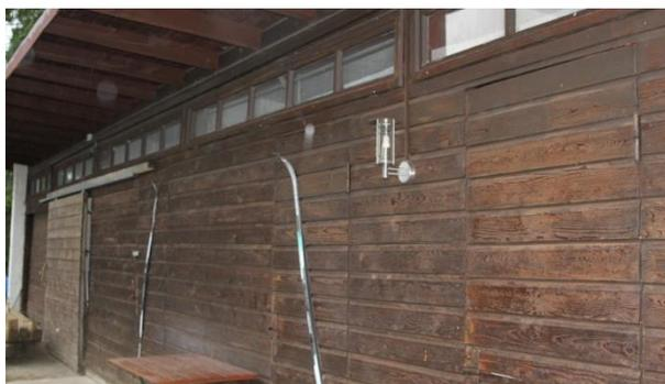
◀Richtung Südost in Richtung Innenhof: An diesem separaten und überdachten Haus sind 2 solche Wand-Leuchten montiert (manuelle Schaltung), die jeweils mit Kompakt-Leuchtstoff-Lampen (7 und 9 Watt) ausgestattet sind. Eine davon (7 Watt, nicht im Bild) ist komplett unter dem Dach, das beide Häuser verbindet. Diese stört somit gar nicht.
