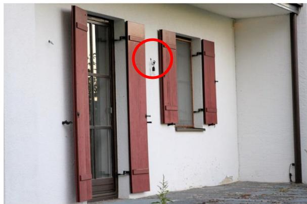
WSW-Seite: Lose Fassung mit einer 40 Watt Glühlampe. Von Innen schaltbar.
