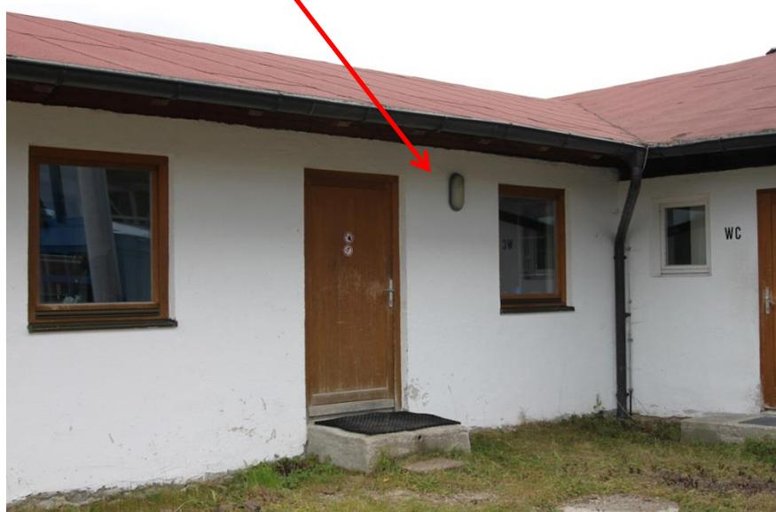
Wand-Leuchte, strahlt Richtung West. Die einzige Außenbeleuchtung der gesamten Anlage. Manuelle Schaltung. Leuchte ist hoch genug unter dem vorstehenden Dach montiert, so dass oberhalb der Waagrechten nichts abgestrahlt wird..
