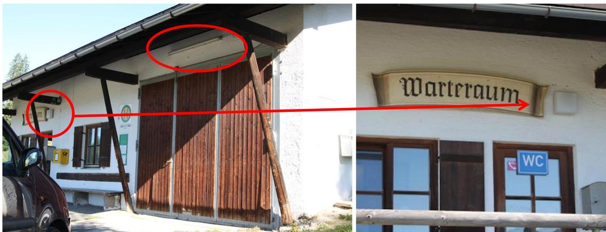
Außen, jeweils unter dem Dach: Eine Leuchtstofflampe (1m Länge) und eine Wandleuchte (mit 75 Watt Glühbirne). Abstrahlung in Richtung SSW
