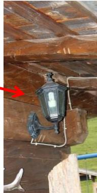
◀ Auf der rechten Seite der Hütte ist eine Wand-Laterne montiert mit einer 8 Watt Kompaktleuchtstoff-Lampe (warmweiß, 450 Lumen), die in Richtung S-Seite abstrahlt.
