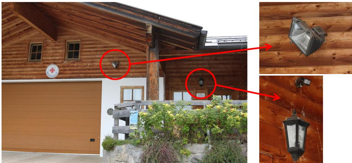
Bergwacht-Haus (SSW-Seite): 1 Halogen-Fluter unter breitem Vordach, der evtl. noch etwas geneigt werden könnte. 1 Wandleuchte mit 46 Watt Halogenlampe.
