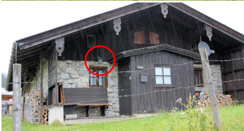
◀ Diese Hausseite ist in Richtung ONO ausgerichtet. Dort ist 1 Wand-Laterne mit trübem Glas installiert. Leuchtmittel: 30 Watt Halogen- Lampe. Manuell geschaltet. Das Dach ragt dort knapp 2m über. Hier kommt es zu einer leichten Abstrahlung über der Waagrechten
