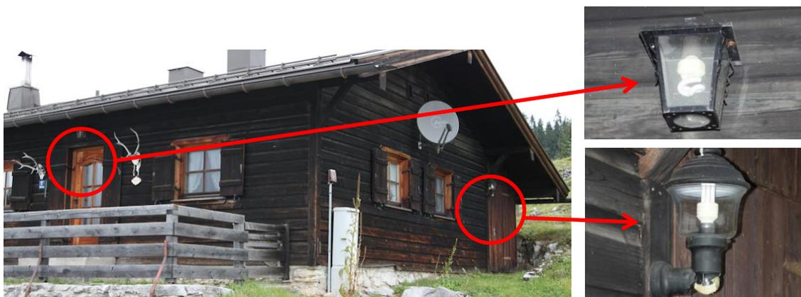
Haus rechts daneben: 2 Wand-Laternen mit je einer 15 Watt Kompaktleuchtstoff-Lampen (in Richtung SSW und OSO). Beide manuell geschaltet.
