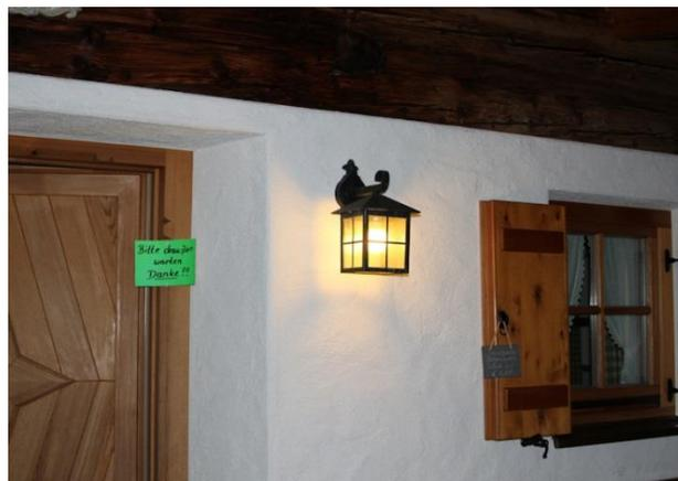
Auf der SSW- und WNW-Seite sind 3 solche (unten offenen) Glas-Laternen, je mit warmweißen 9 Watt Kompaktleuchtstofflampen (ca. 380 Lumen).
