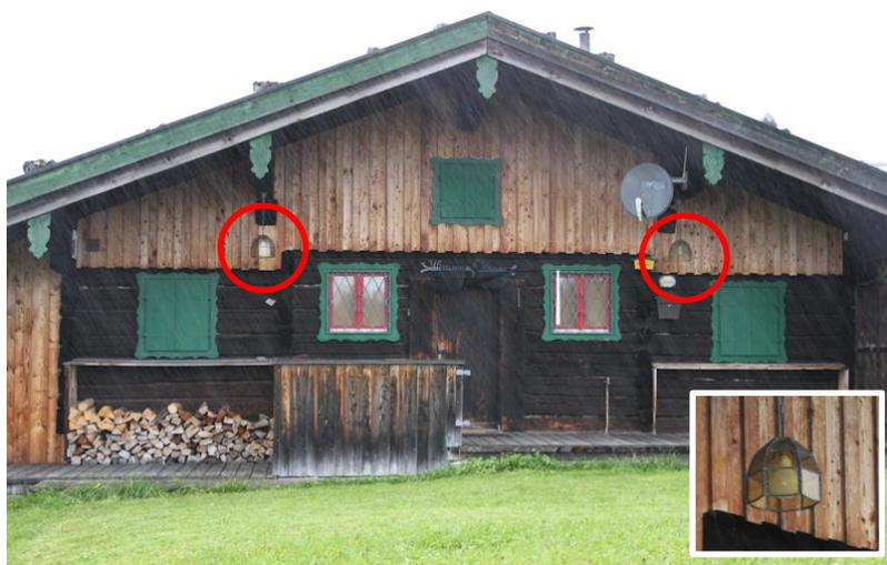
◀ Hier sind zwei Glas-Hänge-Leuchten mit Abstrahlung in Richtung SSO installiert, mit manueller Schaltung von Innen.
