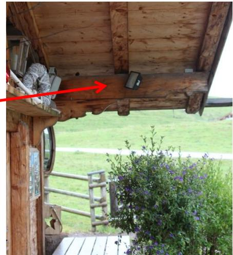
SO-Seite der Hütte: Hier ist unter dem ca. 2 m breiten Dach ein kleinerer, gut geschirmter Halogen-Fluter mit Bewegungsmelder montiert.
