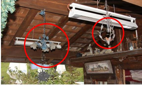
In dieser kleinen Hütte sind unter dem Dach der Hütte insgesamt 2 Hänge-Lampen (jeweils mit 40 Watt Glühlampen) montiert, die manuell geschaltet werden.
