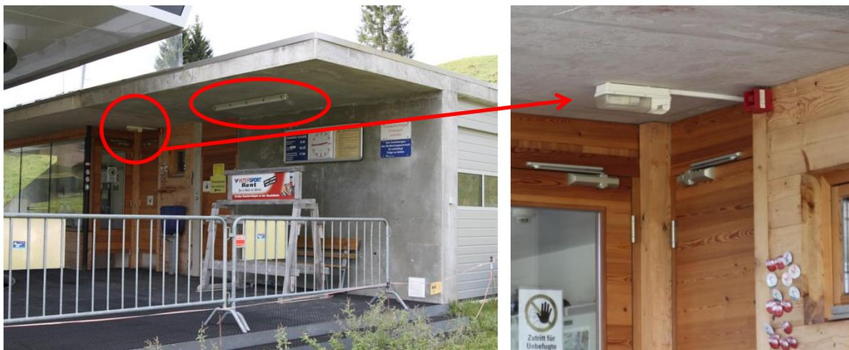
Unter dem Dach des Kassen-Hauses sind 2 Lichtquellen installiert (Abstrahlung in Richtung SSW). 1 Leuchtstofflampe. 1 Kompaktleuchtstoff-Lampe (8 Watt) mit Bewegungsmelder.
