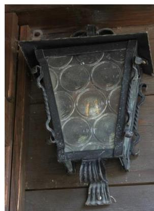
SSW-Seite: 1 Wand-Laterne neben Eingang. Energiesparlampe (9 Watt). Gehäuse unten geschlossen. ▲Gewechselt gegen 2,8 Watt LED 250 Lumen
