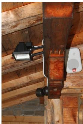
◀ Auf der SW-Seite ist zum Ausleuchten der Eingangstüre ein kleiner Halogen-Fluter mit Bewegungsmelder montiert
