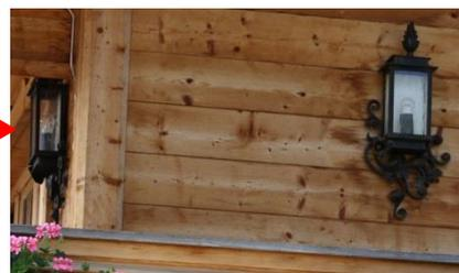
▲Diese Wandleuchten (gesamt 40) sind zwar mit warmweißen Lampen ausgerüstet, strahlen aber bauartbedingt allesamt grell in die Landschaft hinaus ab. Bestückt sind sie mit 30, 42, 46 Watt Halogen- und teils 11 Watt Energiespar-Lampen (zu etwa gleichen Teilen). Installiert sind sie auf der Südost- und Südwest-Seite, und zwar jeweils im Parterre und 1. Stock
