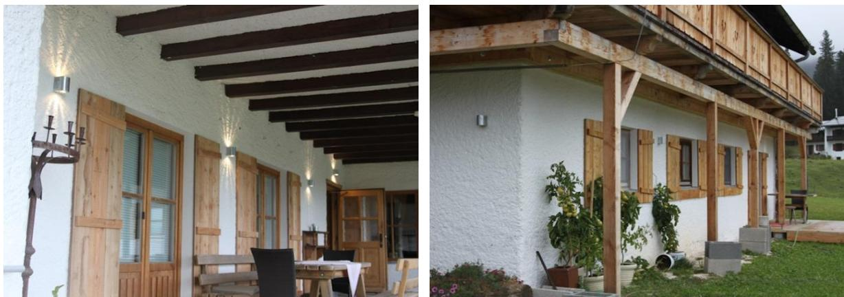
Richtung SO: Insgesamt 7 Wandleuchten (4 davon unter sehr breitem Dach, 3 weitere unter etwa „nur“ ca. 1m breitem Dach (=rechtes Bild). Alle jeweils ausgestattet mit 2700°K warmweißen LED-Leuchtmitteln. Schaltung: nicht bekannt. Vermutlich über Helligkeit/manuell.
