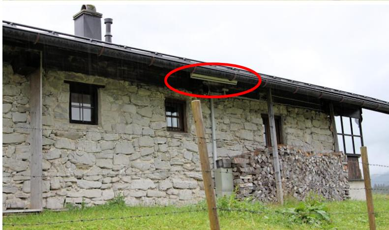
◀ Diese Hausseite ist südlich ausgerichtet. Dort ist unter dem überhängenden Dach eine ca. 1m lange Leuchtstoff-Röhre installiert. Manuell geschaltet. Das Dach hängt ca. 1 m über, so dass es zu keiner seitlichen Abstrahlung über die Waagrechte hinaus kommt.
