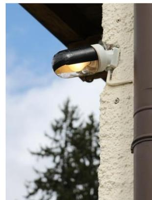
Hier strahlt (in Richtung W) eine Kompakt-Leuchtstofflampe (12 Watt, 700 Lumen) mit Bewegungsmelder. ▲lampe wurde gewechselt + geschirmt.
