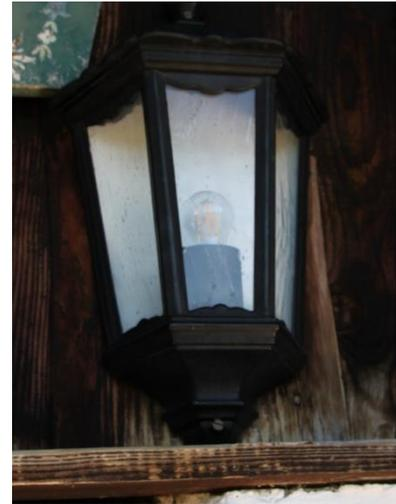
SSW-Seite, 1 Wand-Laterne über der Eingangstüre. 42 Watt Halogenlampe. Wurde am 15.9.17 getauscht gegen eine 2,8 Watt warmweiße LED.
