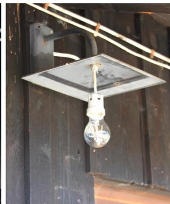
Links daneben diese Hütte mit 1 Laterne (unten transparent) mit Strahlrichtung SO (Halogen 60 Watt, 650 Lumen). ▲Getauscht durch 4 Watt LED
