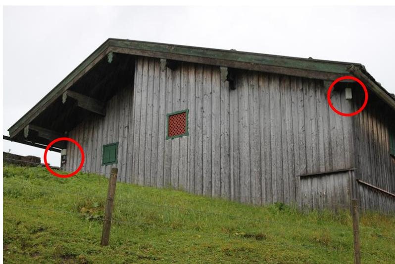
◀ Auf der NW-Seite des Hauses sind zwei Wand-Leuchten angebracht. Vermutlich sind hier auch jeweils Glühbirnen installiert. Beide Leuchten sind unter dem überstehenden Dach montiert (nämlich 0,5 m bis 1,5 m nach innen versetzt). Die Schaltung erfolgt manuell (gemeinsam).
