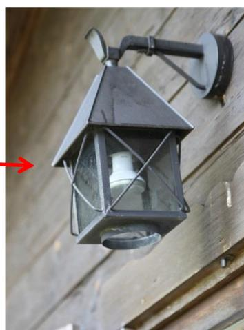
WNW-Seite: 1 Wand-Laterne (unten offen), mit 46 Watt Halogenlampe (700 Lumen). ▲Gewechselt gegen 2,7 Watt LED Reflektor, 210 Lumen
